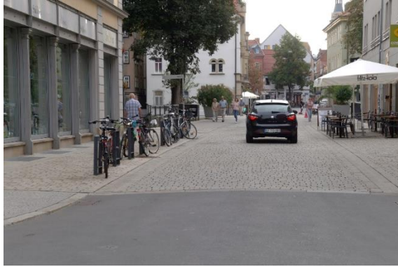
Weiche Trennung zwischen Fahrbahn und Seitenbereichen, Erfurt
