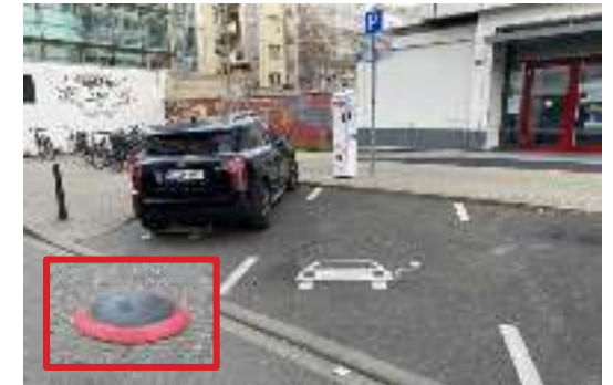
E-Ladeparkstände im Öffentlichen Raum mit Parkstandssensoren
