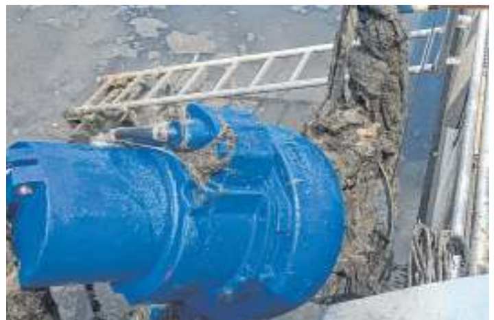
BILD: STADTENTWÄSSERUNG MANNHEIM
