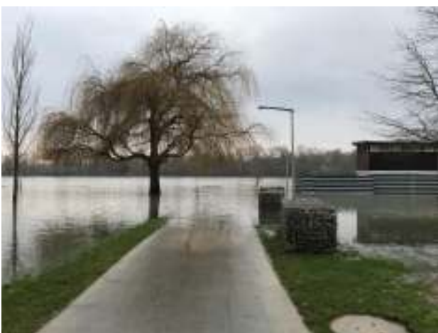
Abb. 31: Überschwemmung am Strandbad Januar 2018 [Foto: Hoffmann]
