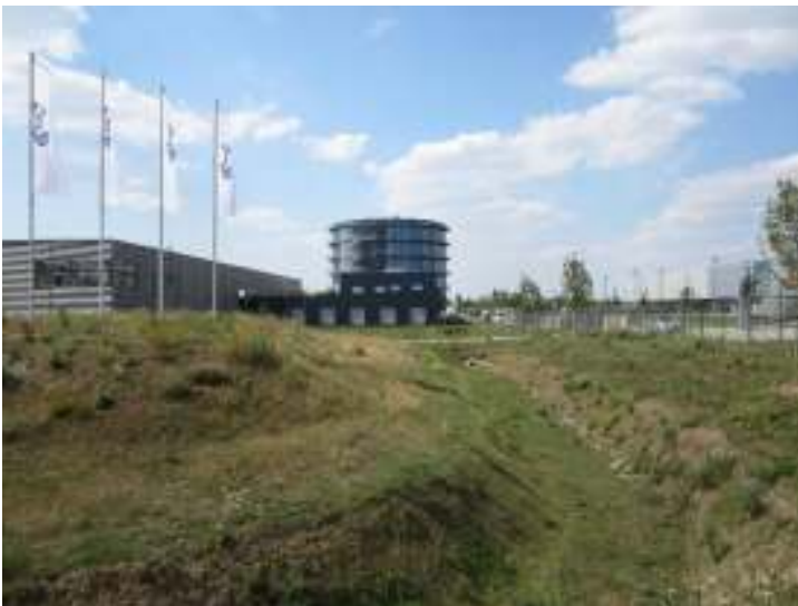
Niederschlagswassersammlung als Maßnahme zur Anpassung an die Folgen des Klimawandels in KMU [Foto: Schönfelder]
