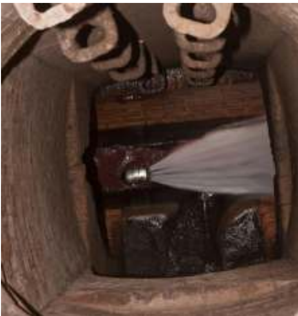
Abb. 33: Spüldüse im Kanal [Foto: EBS, 2012]
