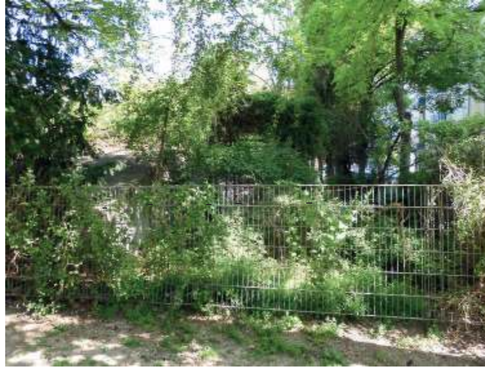
Zaunanlage und Gehölzflächen am südlichen Platzrand
