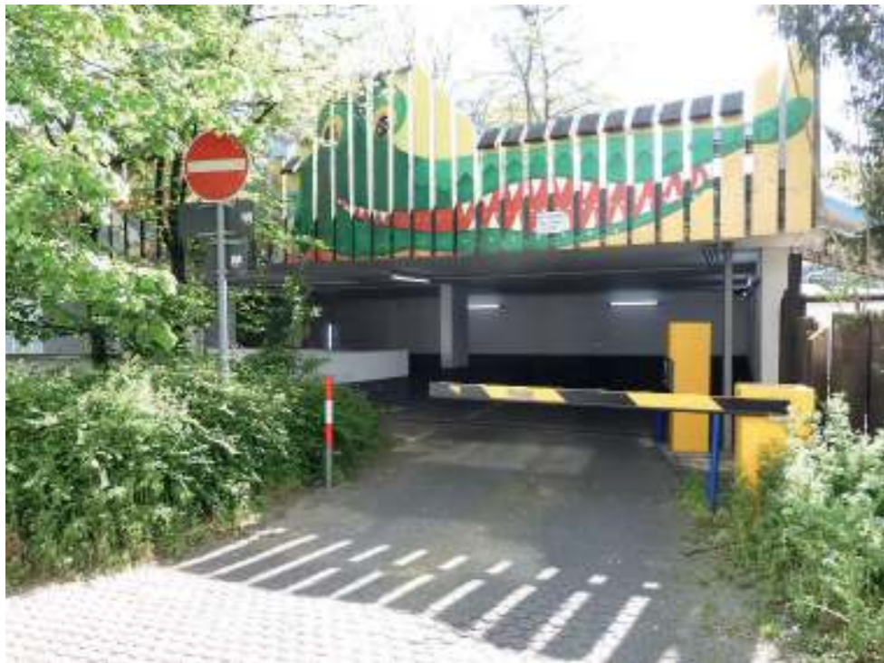
Die Ausfahrt der Tiefgarage
