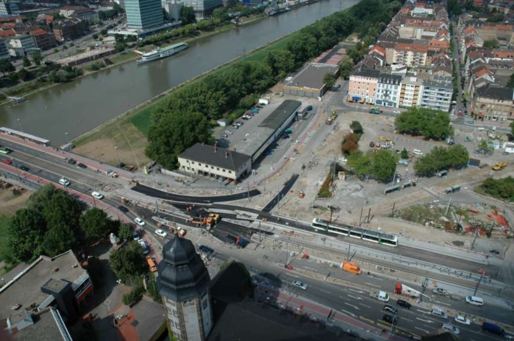
2005 Umbau Alter Meßplatz
