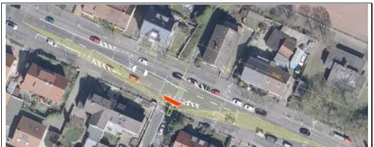
Abbildung 5: Einmündung „Guter Fortschritt“ mit Querungshilfe auf der westlichen Seite und mit den erforderlichen Sichtfeldern
