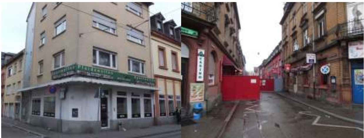
Abbildung 24: Wettbüro in der Mittelstraße (li.), „abgeschotteter“ Eingangsbereich zur Lupinenstraße (re.) (Quelle: Fotodokumentation)
