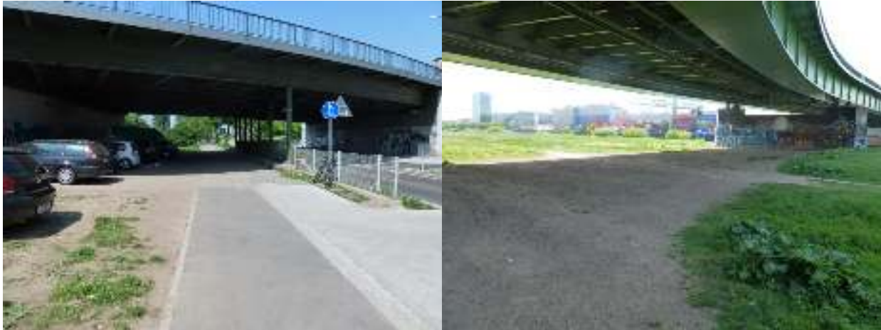
Abbildung 35: Unterführung Jungbuschbrücke (li.) und Wiese unterhalb des Brückenbaus (re.) (Quelle: Fotodokumentation)
