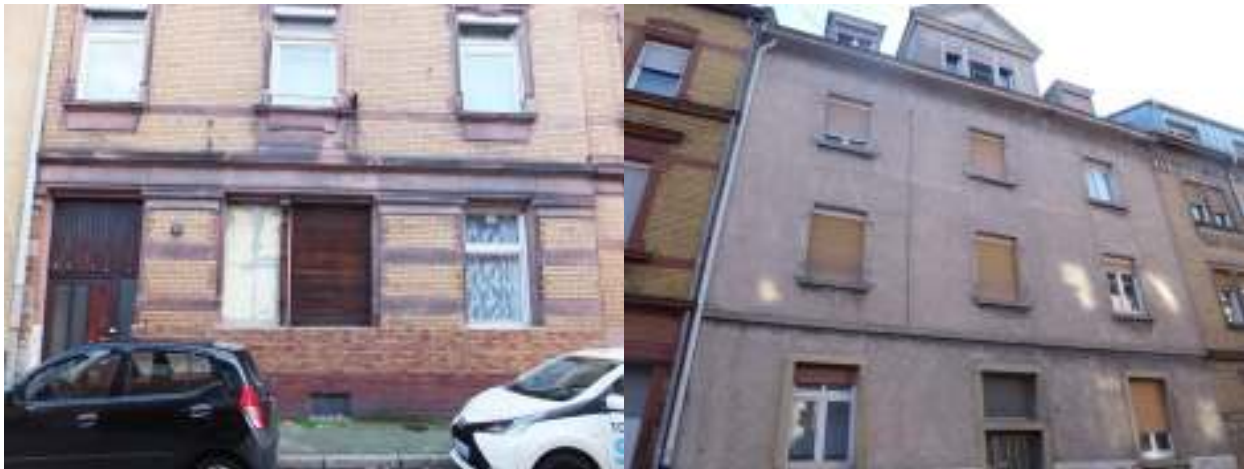
Abbildung 22: Gebäude mit deutlich sichtbaren baulichen Mängeln und (vermutetem) umfassenden Sanierungs- und Modernisierungsbedarf (Quelle: Fotodokumentation)
