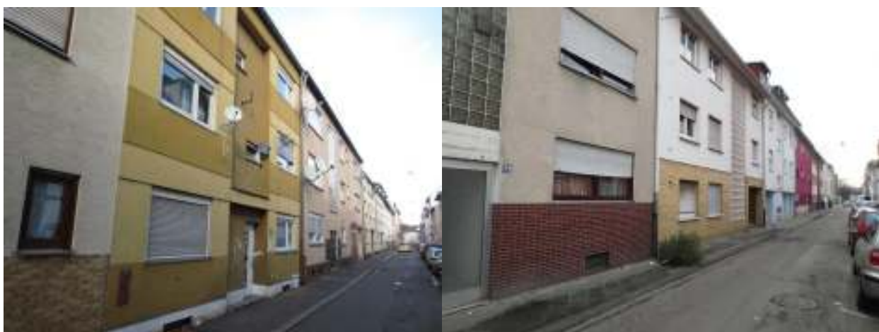
Abbildung 21: Typische Gebäude mit mittlerem baulichem und energetischem Sanierungsbedarf (Quelle: Fotodokumentation)
